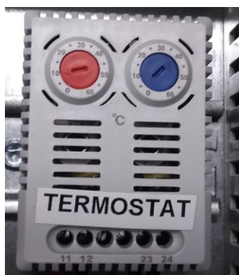
Rys.2.7.1. Termostat z ustawionymi standardowymi wartościami temperatur
