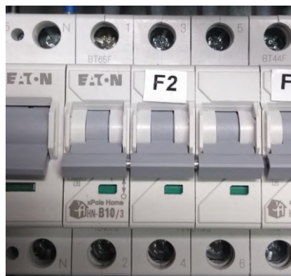
Rys.2.2.1. Wyłącznik nadprądowy F2
