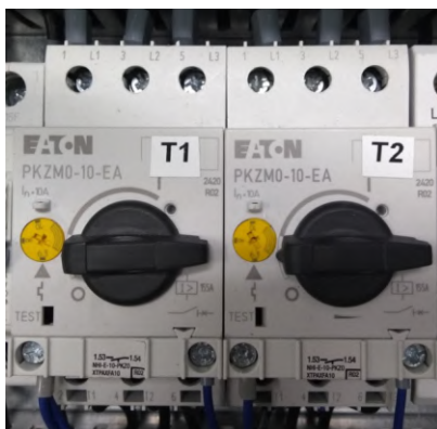
Rys.2.5.1. Wyłączniki silnikowe
