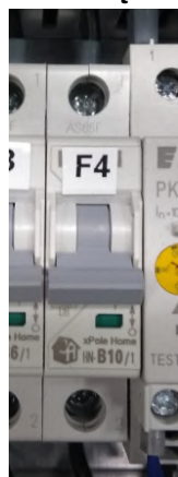
Rys.2.4.1. Wyłącznik nadprądowy F4
