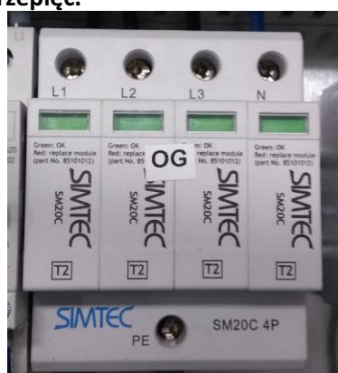
Rys.2.6.1. Ogranicznik przepięć
