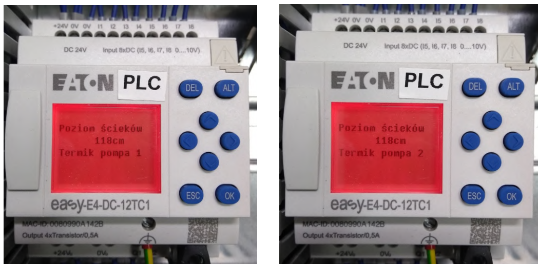
Rys.3.6.1.Ekran zdarzenia: Termik pompa 1 oraz Termik pompa 2
