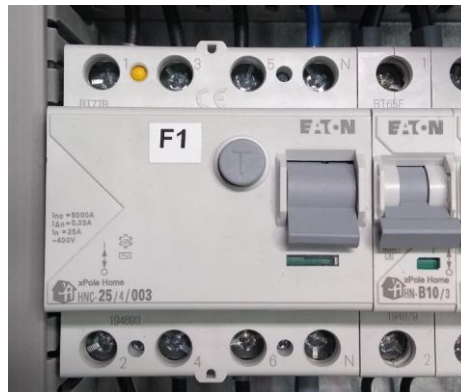
Rys.2.1.1. Wyłącznik główny F1
