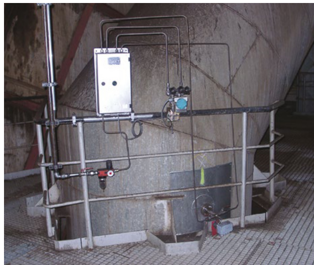
DF25 z systemem czyszczenia powietrzem LSP do powietrza spalania zawierającego cząsteczki pyłów z podgrzewacza powietrza.
