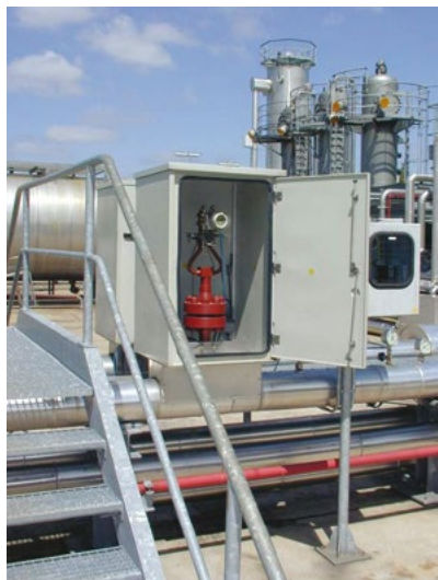
DF25HDD3 dla gazociągów wysokociśnieniowych za wiertłem.
